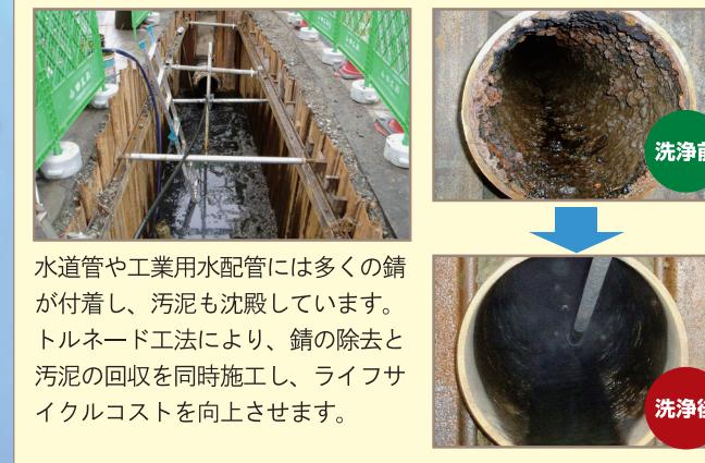
水道管や工業用水配管には多くの錆が付着し、汚泥も沈殿しています。トルネード工法により、錆の除去と汚泥の回収を同時施工し、ライサイクルコストを向上させます。
