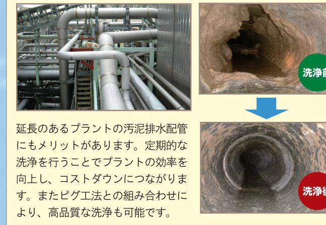
延長のあるプラントの汚泥排水配管にもメリットがあります。定期的な洗浄を行うことでプラントの効率を向上し、コストダウンにつながります。またピグ工法との組み合わせにより、高品質な洗浄も可能です。
