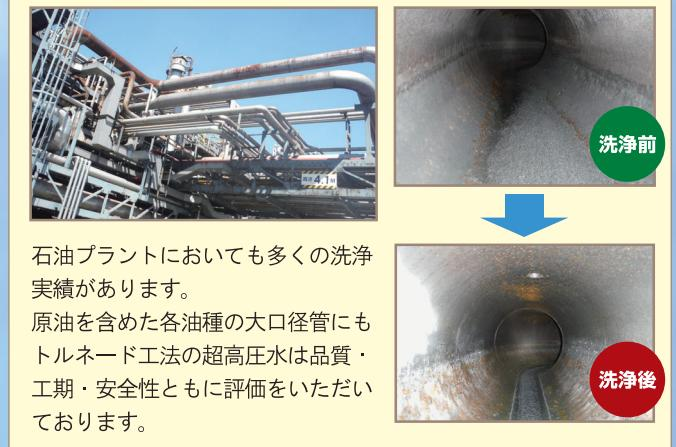
石油プラントにおいて多くの洗浄実績があります。原油を含めた各油種の大口径管にもトルネード工法の超高圧水は品質・工期・安全性ともに評価をいただいている 있습니다。
