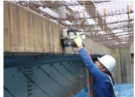
NO,3 施工状況
