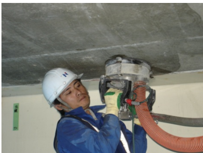
NO,4 施工状況
