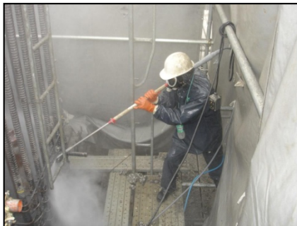
NO,5 施工状況
