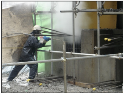
NO,2 施工状況
